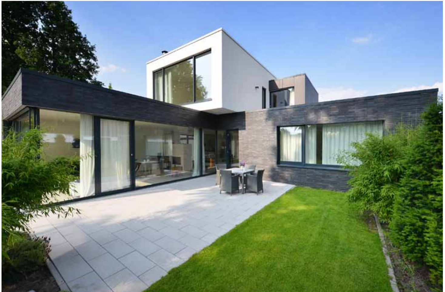
Dunkle Klinker, weißer Putz und anthrazitfarbene Faserzementplatten grenzen die verschiedenen Baukörper voneinander ab und definieren die verschiedenen Wohnbereiche.
